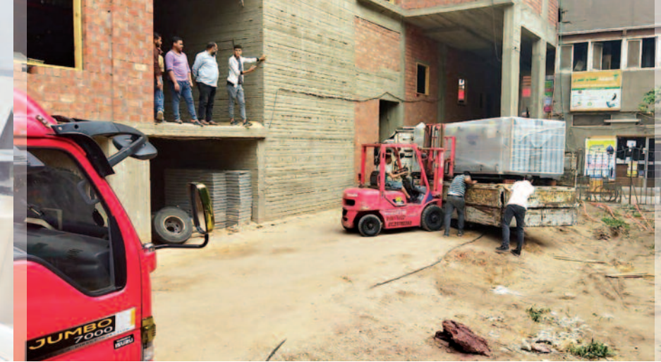
Die Klimaanlage wird angeliefert ...
