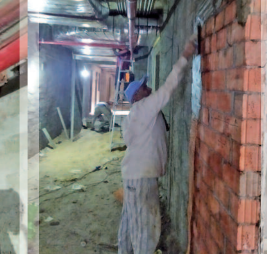
Die Wände werden verputzt.
