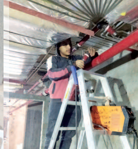
Die Brandschutzanlage wird installiert.
